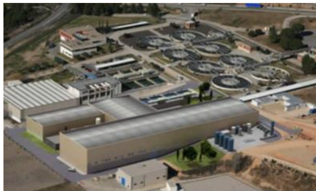
Figura 1: Estación de tratamiento de agua potable (ETAP) del Llobregat.
