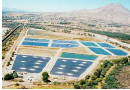
Figura 1: Plantas de tratamiento de aguas servidas de Ambos Nogales mediante tecnología de lagunas aireadas (México – EEUU).
