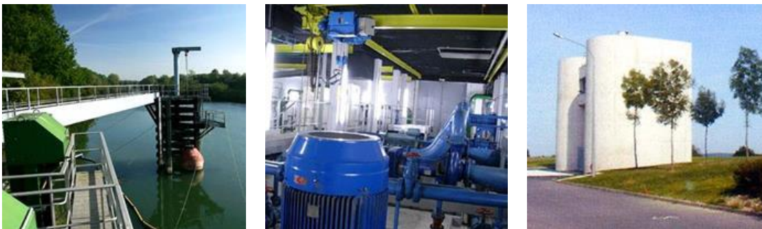
Figura 1: Planta potabilizadora Annet - Sur - Marne
