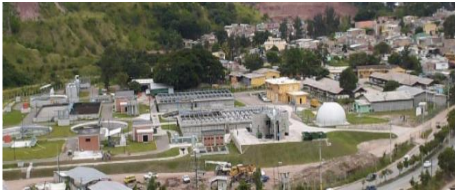
Figura 1: Sistema híbrido UASB-Lodos Activados Convencional en escala real para el tratamiento de aguas residuales domésticas de la ciudad de Tegucigalpa, Honduras.
