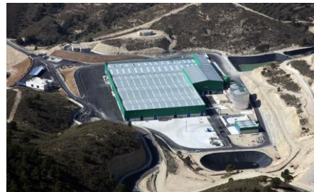
Figura 1: Planta de biometanización 40.000 t/año en centro de tratamiento residuos sólidos, El Campello, Alicante, (España).
