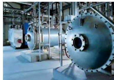
Figura 2: Desinfección por ozono.
