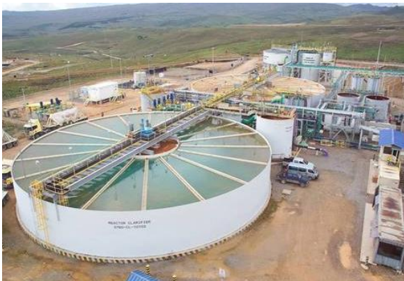
Figura 1: Planta tratamiento neutralización industria minera.
