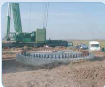
Figura 10: Fundaciones de un aerogenerador de 1.750 kW y base de un aerogenerador de 2.000 kW
