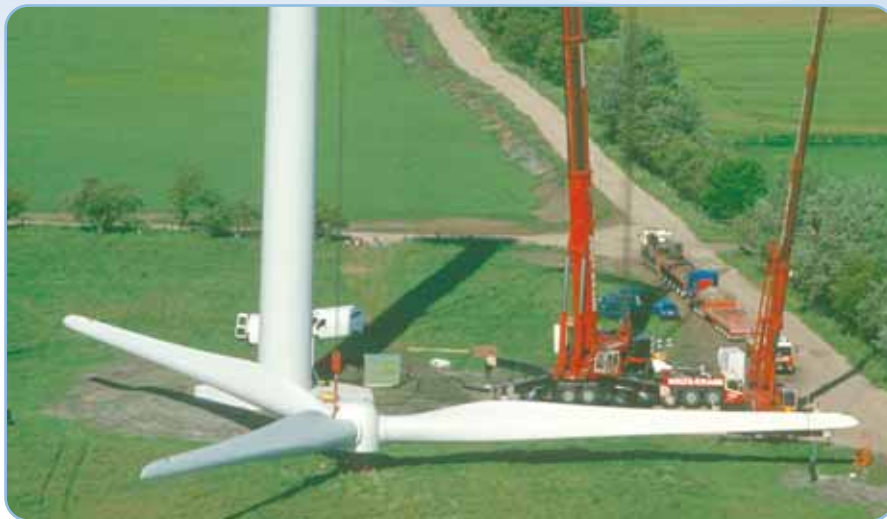
Figura 6: Montaje de un rotor
