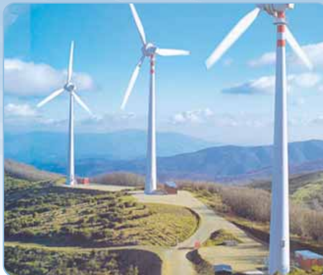
Figura 15: Caminos para los aerogeneradores
