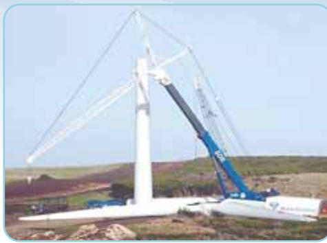
Figura 16: Fase de construcción
