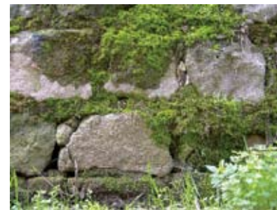
Foto 3. Briófitas habitando bloques de piedra y concreto.
