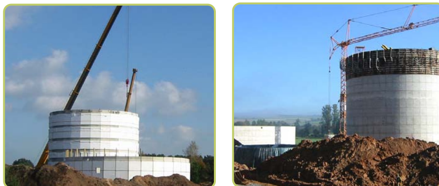
Figura 7: Planta de biogás en construcción
