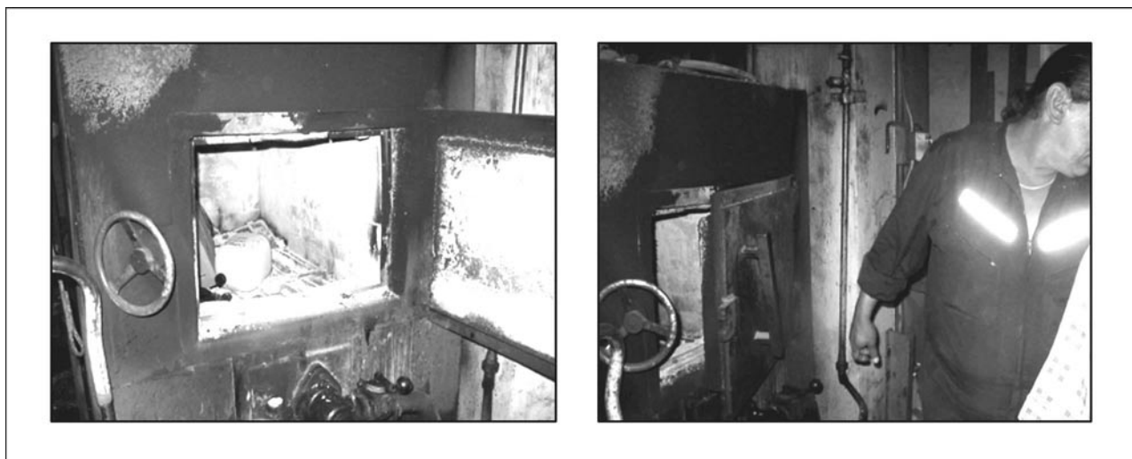
FIGURA 36: CALDERA QUE SE UTILIZA EN EL HOSPITAL PARA LA INCINERACIÓN DE RESIDUOS MÉDICOS
