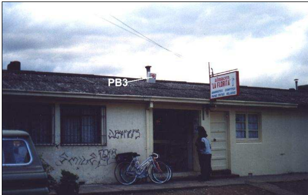
Ilustración 10.3.1-Estrato 3: En el Techo de la casa ubicada en Varas con Bilbao.
