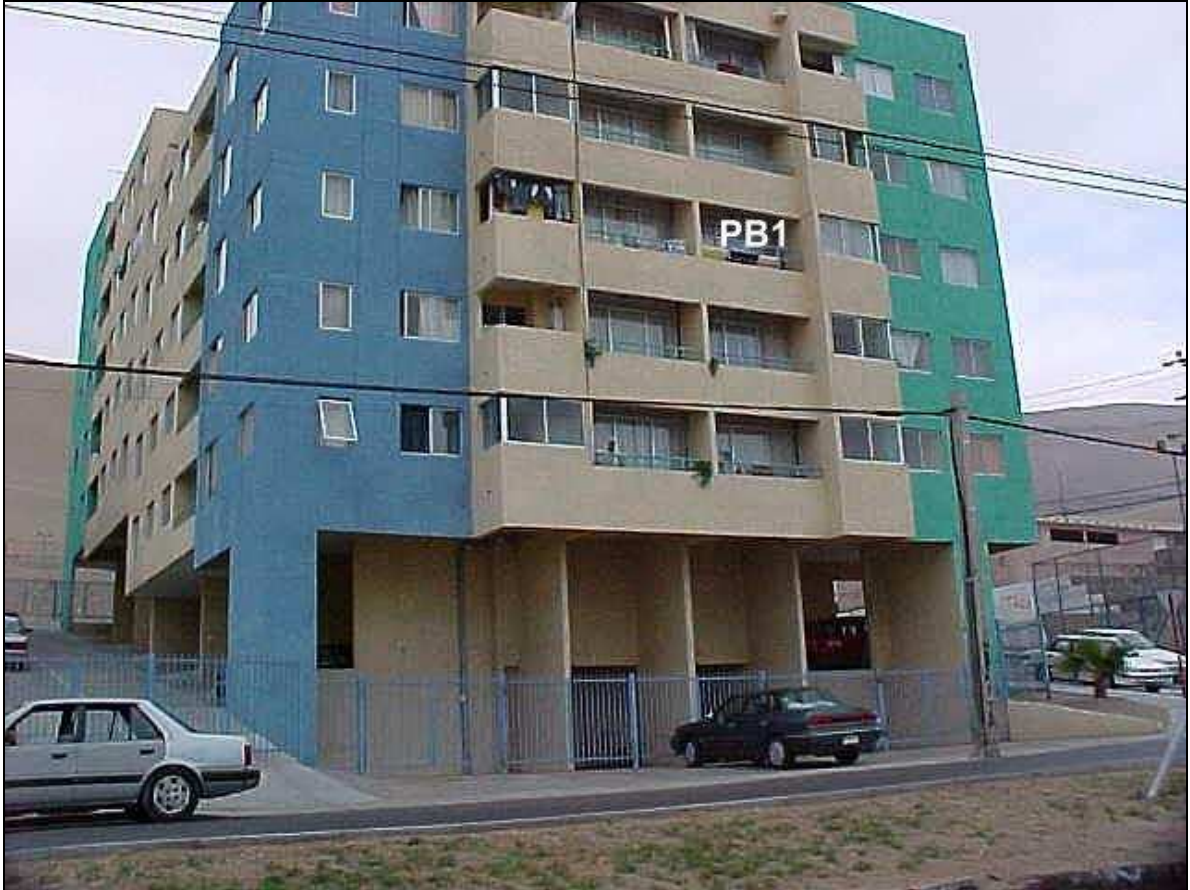
Ilustración 10.3.2.1 Estrato 1: En el patio del departamento 3 er piso ubicado Calle 4 #2604 Depto.31 Condominio San Andrés. (Chipana con Av. La Tirana).
