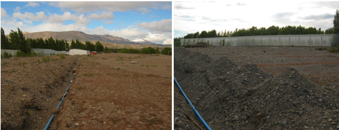
Figuras 28 y 29: Estado actual de la hectárea de conservación de Agrícola Patagonia Cherry. La idea sería instalar un cactario en ese sector.
