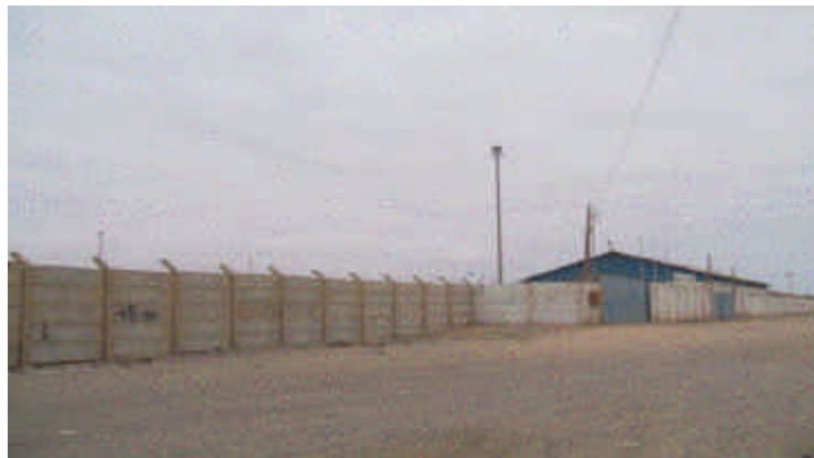
Figura 23. Sector F del Barrio Industrial. Arica.
