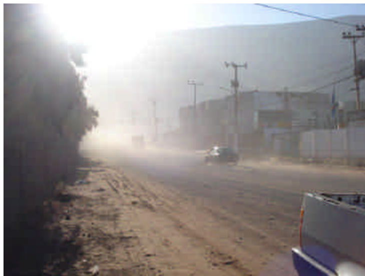
Figura 6. Fotografía tomado a Calle Vía 1, donde muestra el problema de fuentes difusas (resuspensión del material particulado por la circulación de vehículos en calle sin pavimentar. Sector Bajo Molle. Iquique.
