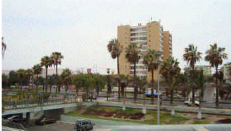
Figura 18. Fotografía, vista Este de la Estación (ACAS) hacia la Avda. General Velasquéz. Arica.
