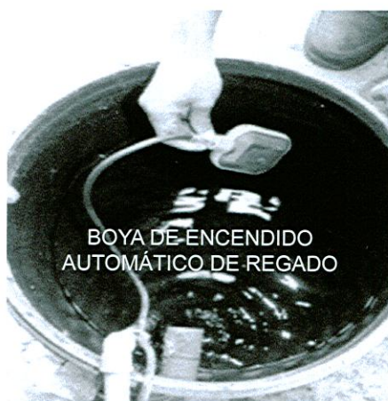
Figura 4: A la izquierda se encuentra señalado el dispositivo (interruptor de nivel) y a la derecha se indica la salida de agua de rebalse.
