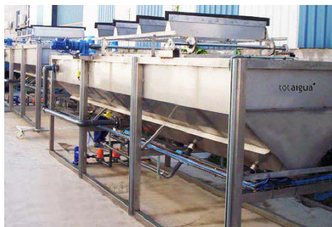
Figura 1: Equipos de flotación por aire disuelto, DAF
