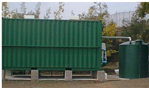
Figura 2: Equipo SBR de Empresa Napier-Reid
