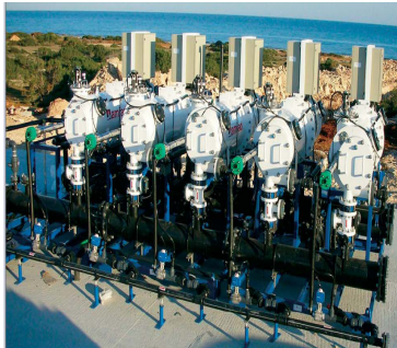
Figura 1: Planta de desalinización, Chipre.
