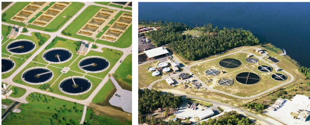
Figura 1: Vistas aéreas de plantas de tratamiento de aguas servidas con la tecnología de lodos activados
