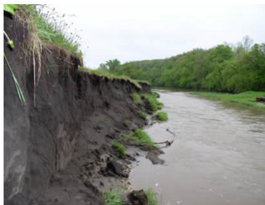
Figura 2.1 Erosión en las laderas producto de la ausencia de vegetación ripariana.
