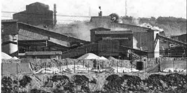
Las chimeneas de Ventanas están a un metro de la escuela La Creola, que la semana pasada fue cerrada por contaminación.
