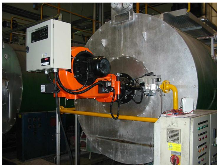
**Figura 4: Caldera a Gas con Quemador Presurizado**
