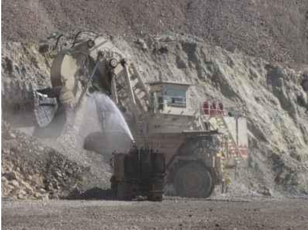
Figura 5-21. Carga de Material en Camión con Pala Mecánica
