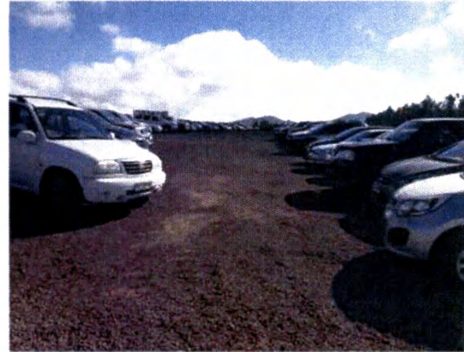
Zona de rodado con mezcla de gravilla y Petrosoil® (polímero supresor de polvo)
