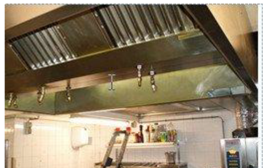
Keuken met afzuigkap boven de trap de voorfilters en 32 actiefkoolfilters
