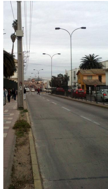
Estación Calle Amunátegui – La Serena Tipo Vía Troncal Sin Loc. Col..
